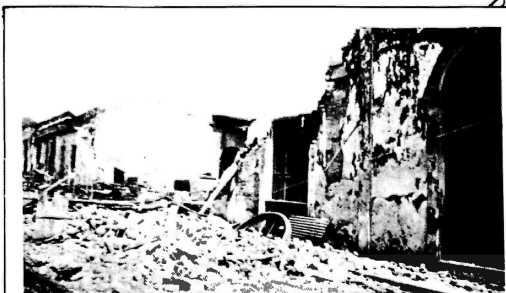
Ruinas del edificio del Círculo de Artesanos, en San Antonio de los Baños.
